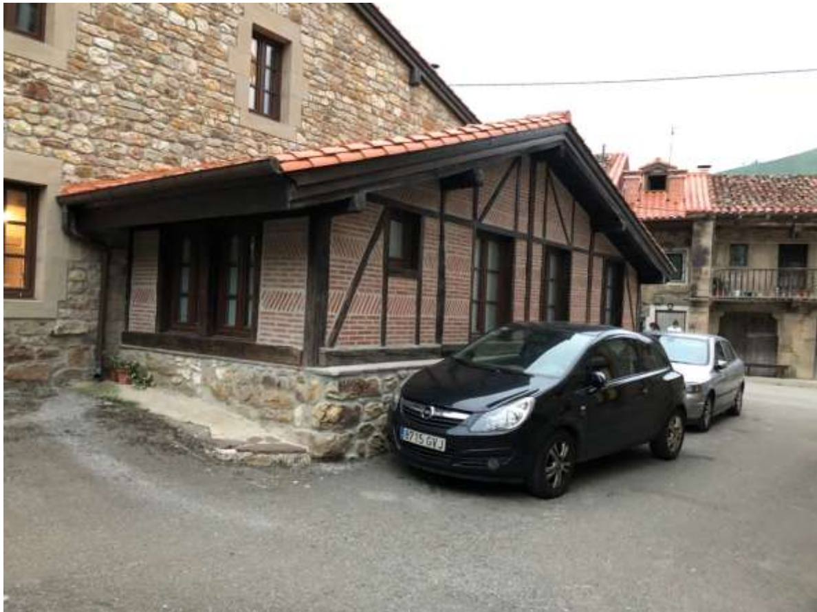
Foto 31: Vivienda construida donde en 1962 existía una socarreña
